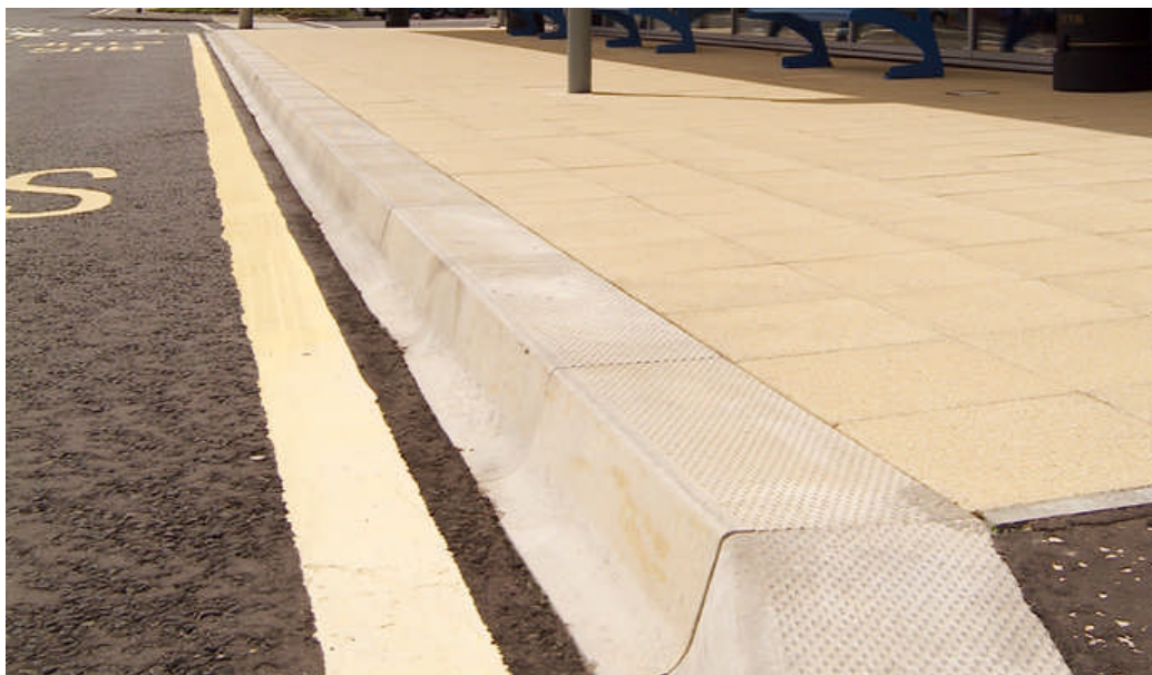
7-21. ábra: Íves oldalfalú szegélyelem alkalmazása buszöbölben (forrás: Google)
