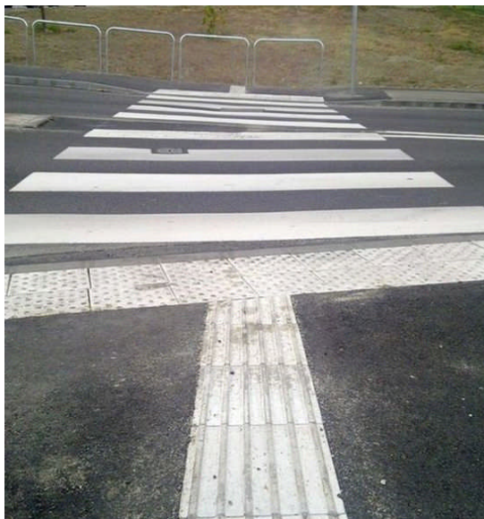
7-22. ábra: Taktilis burkolati elemek kialakítása gyalogos átkelőhely esetén
