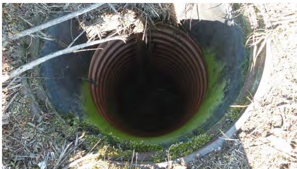
24. a fejlesztési terület közművesítésének bevezetéseként létesült csatorna mély, fedetlen aknája, ami komoly balesetveszélyt jelent és amiben állatok pusztulnak el
