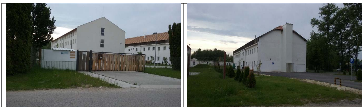
Komárom utcai ingatlanok a Mozsár utca és a Kürt utca közötti szakaszon
